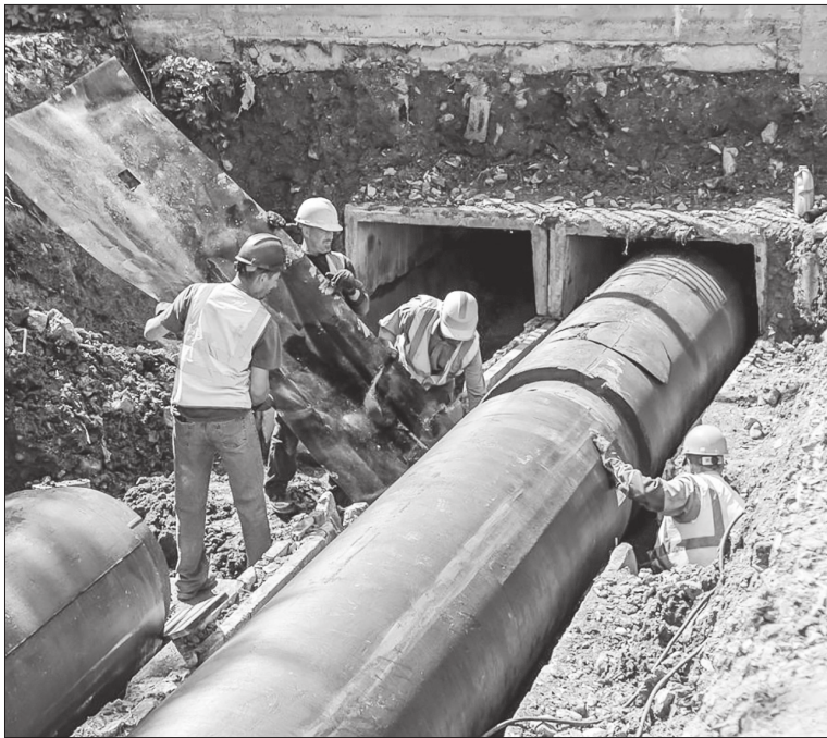
На всех объектах проведены гидравлические испытания заменённых сетей, подтвердившие их готовность к эксплуатации
