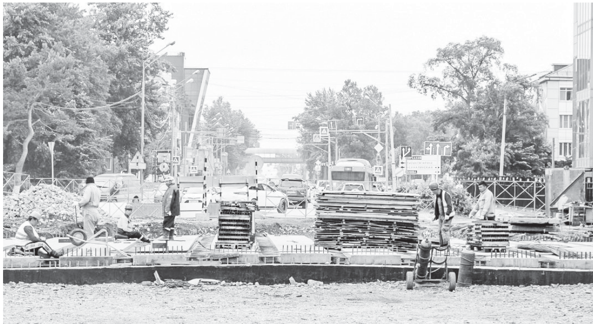
■ СТРОИТЕЛЬСТВО МОСТА через Рогатку в числе приоритетов
