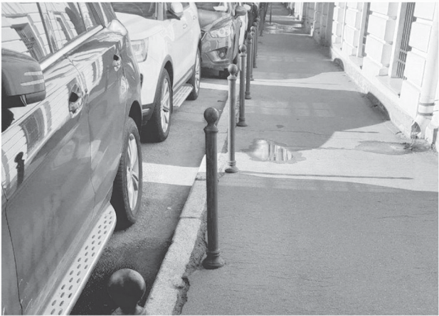
ПЛОХО. Покрытие пешеходного тротуара асфальтобетоном недопустимо
