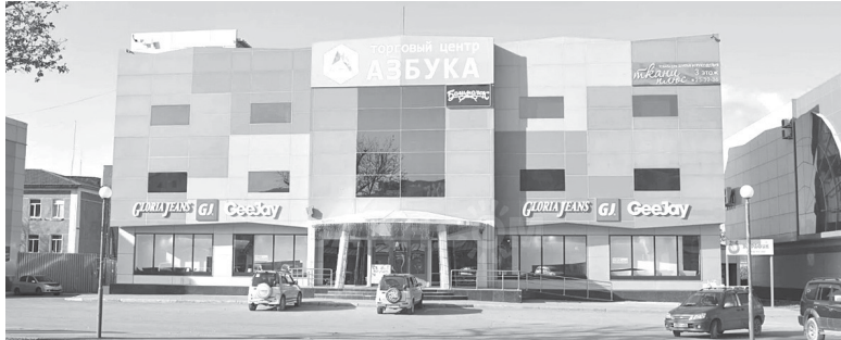
► Так сейчас выглядит здание будущей библиотеки
