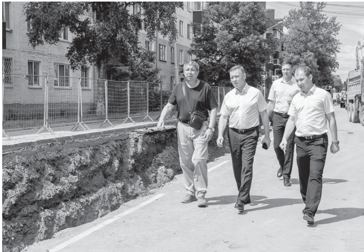
■ МЭР ЮЖНО-САХАЛИНСКА провел выездное совещание в центре города, где идет перекладка магистрального трубопровода Чеховского коллектора
