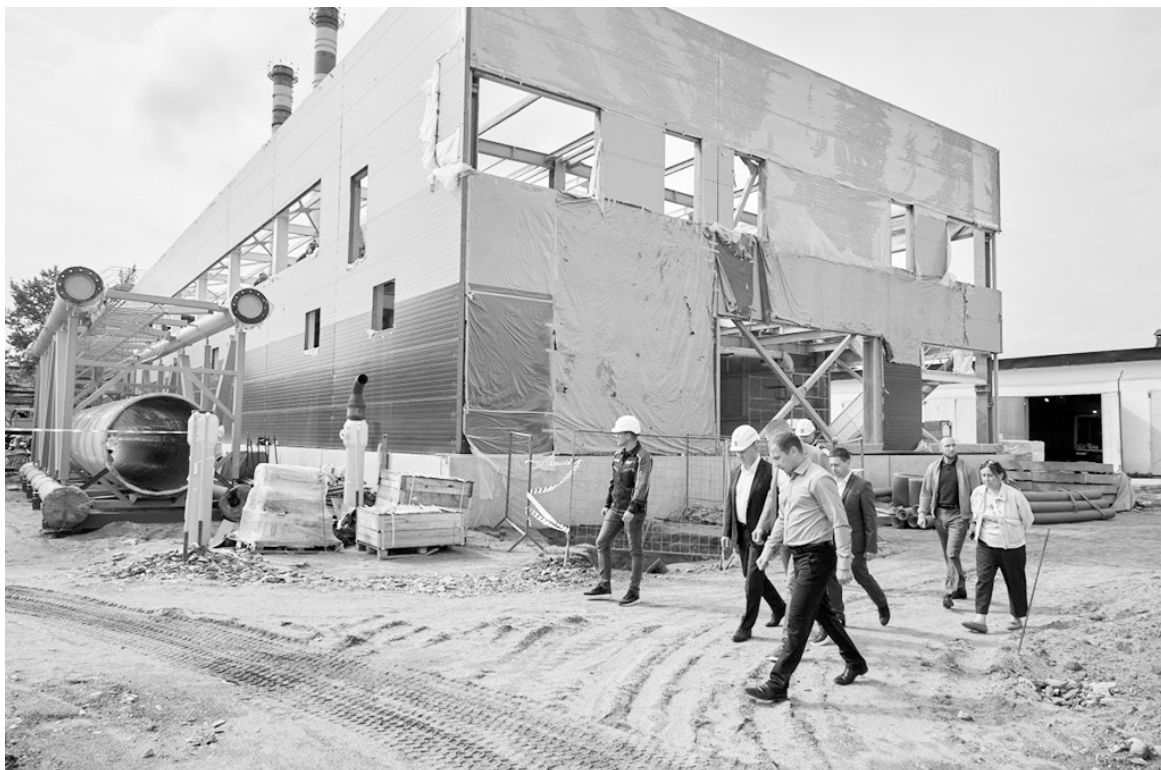
■ НА СТРОИТЕЛЬНОЙ площадке
