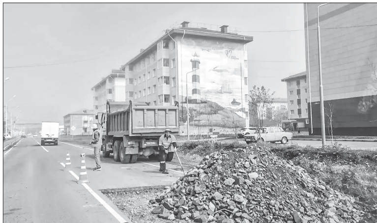
📍 В Поронайске на улице 40 лет ВЛКСМ специалисты демонтировали старый асфальт, чтобы положить новый. / ПРЕСС-СЛУЖБЫ АДМИНИСТРАЦИИ ПОРОНАЙСКОГО РАЙОНА
