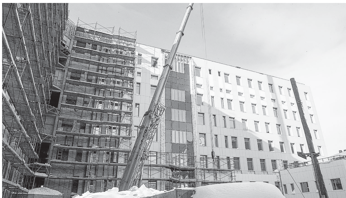
■ СТРОИТЕЛЬСТВО корпуса для КДЦ близится к завершению.
