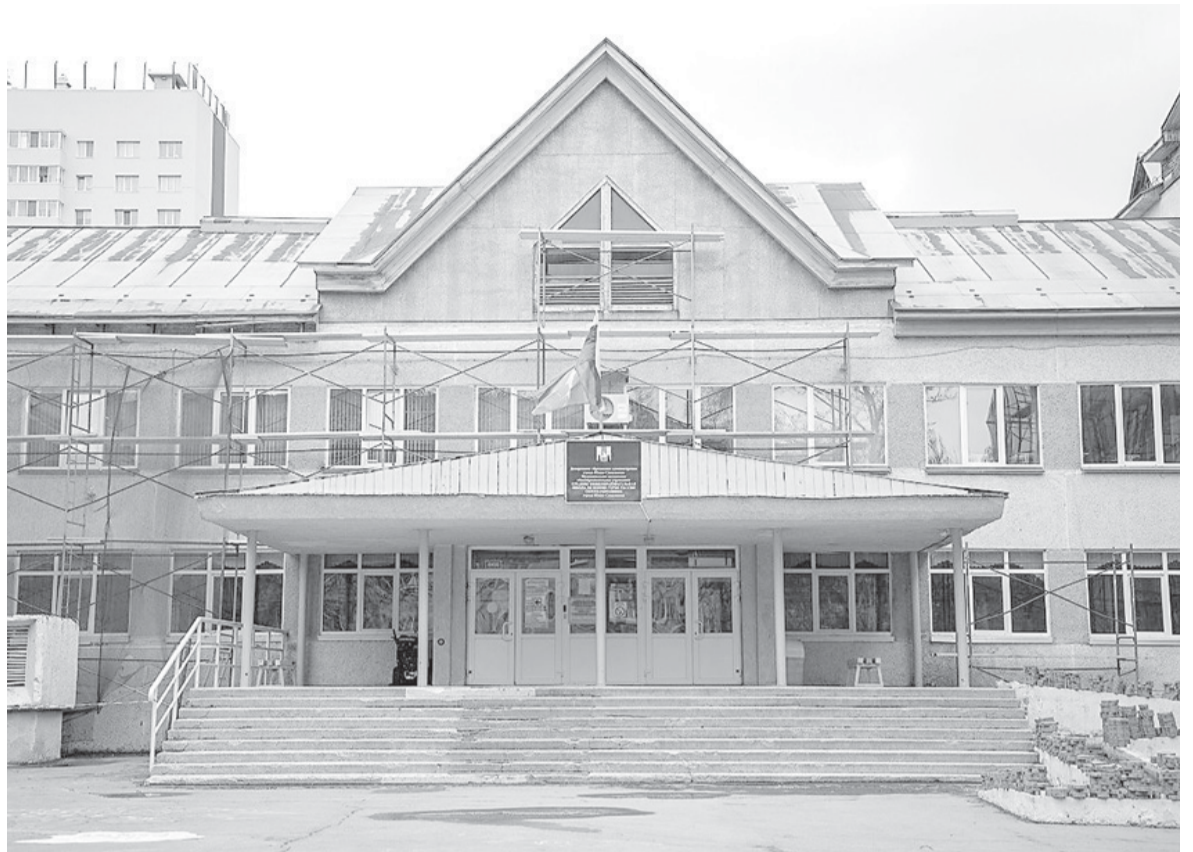
► Обновляются фасад и входная группа школы № 3
