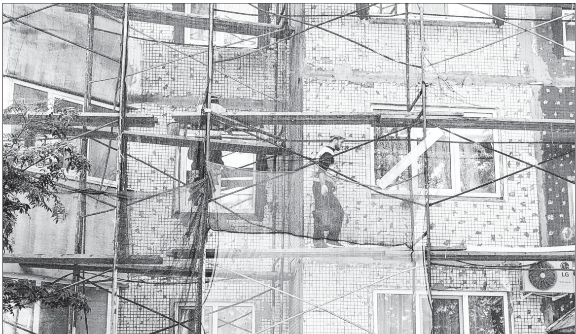
■ Не забыли в этот сезон и про ремонт фундаментов, фасадов, крыш. К слову, в регионе кровли планируется поменять до конца года на 50 домах. Столько же преобразится и фасадов. / ФОТО ПРЕСС-СЛУЖБЫ ПРАВИТЕЛЬСТВА САХАЛИНСКОЙ ОБЛАСТИ
