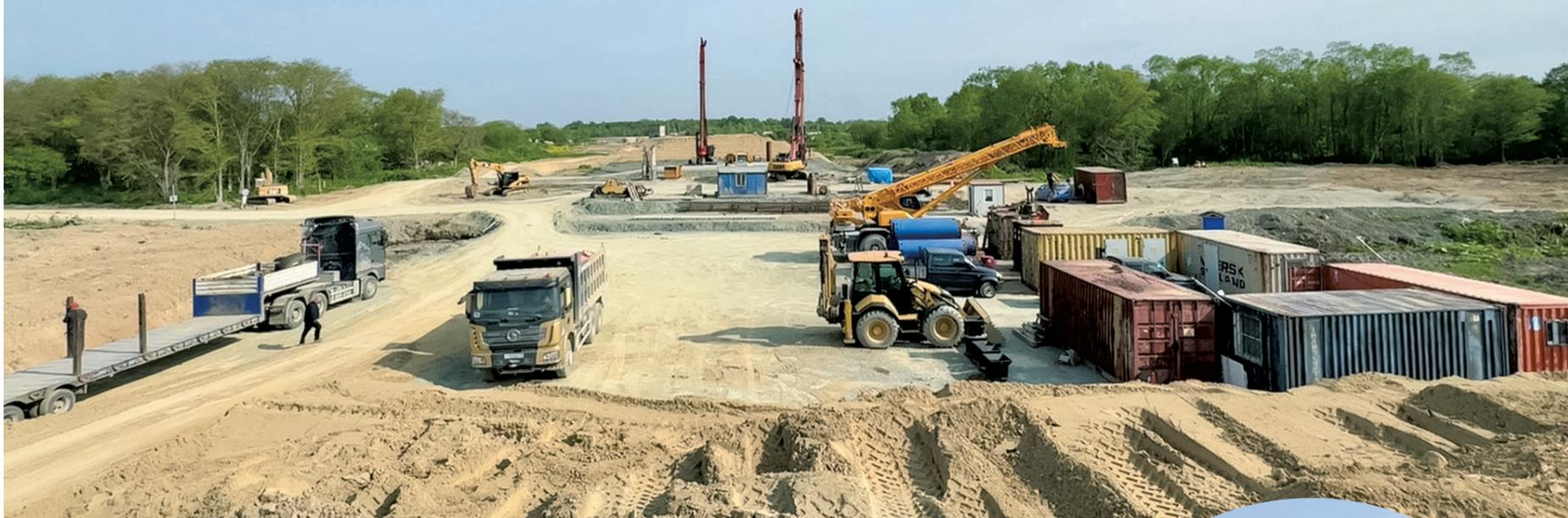
Специалисты должны переложить коммуникации, в том числе ЛЭП и нефтегазопроводы, построить четыре моста и путепровод, дорожное полотно. В дальнейших планах – установка водоотводных лотков, ограждений и дорожных знаков, укладка асфальтобетонного покрытия.
