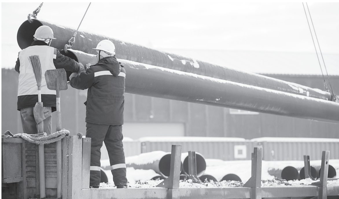
Укладка тепловых сетей для Южной газовой котельной
