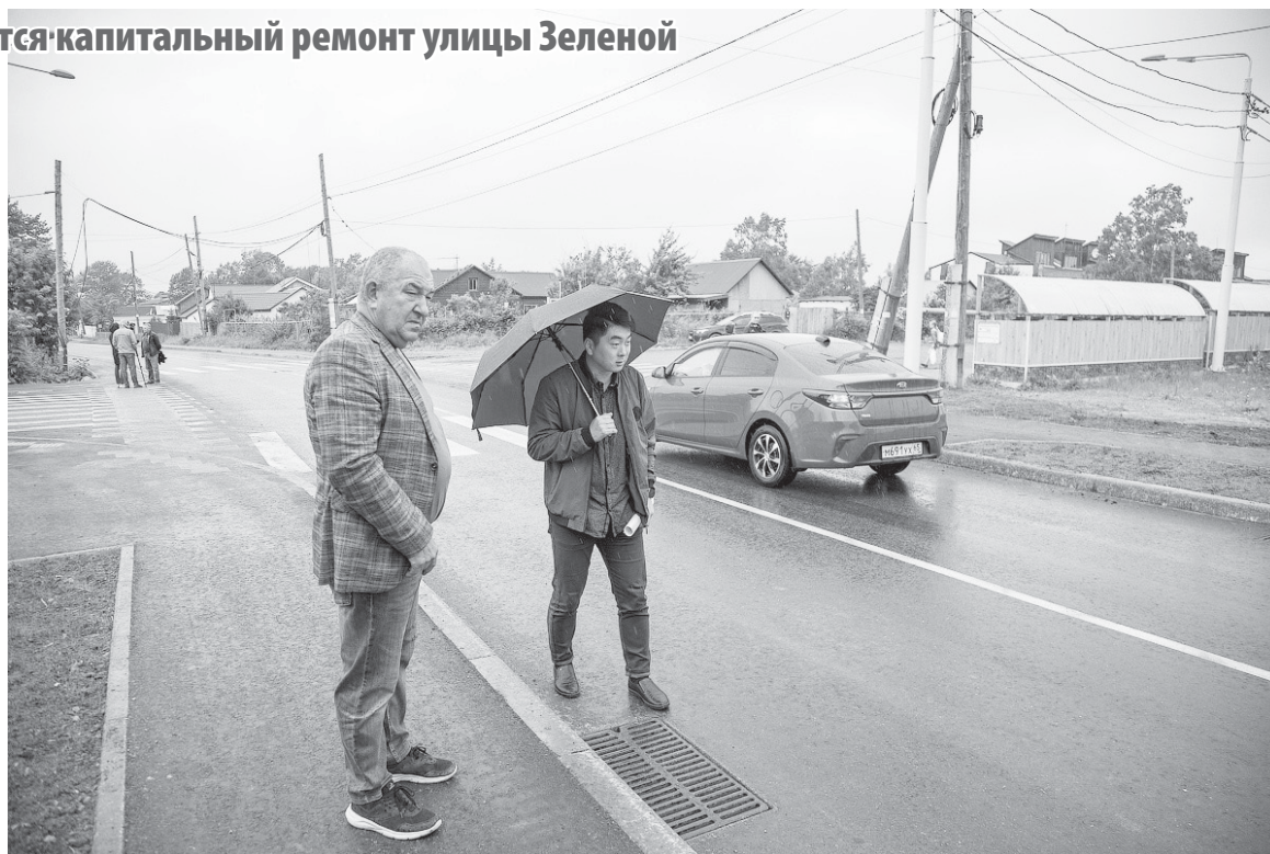
■ ЧЛЕНЫ ДОРОЖНОГО СОВЕТА, СПЕЦИАЛИСТЫ МЭРИИ ТЩАТЕЛЬНО ОТСЛЕЖИВАЮТ КАЧЕСТВО РЕМОНТА
