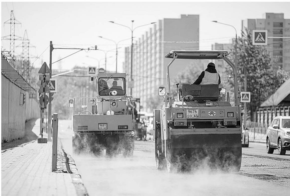
■ В СЛЕДУЮЩЕМ ГОДУ бюджетные средства также будут направлять на ремонт дорог
