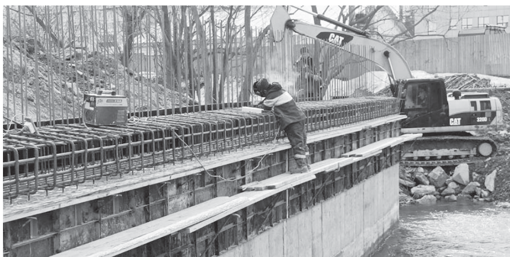
■ ИДЕТ строительство нового моста
